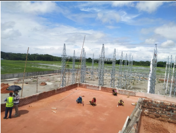
Fig:4.10. Lime terracing work on CRB slab
