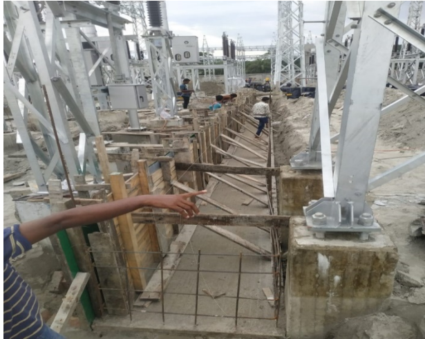
Fig: 4.12. Cable trench wall shattering work
