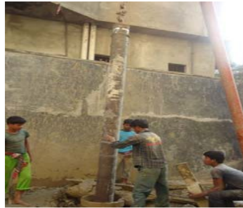
Fig: 3.6.Core/tremie pipe
