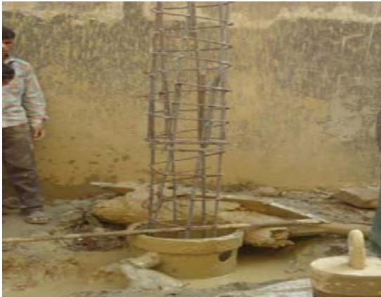
Fig: 3.5.Reinforcement cage
