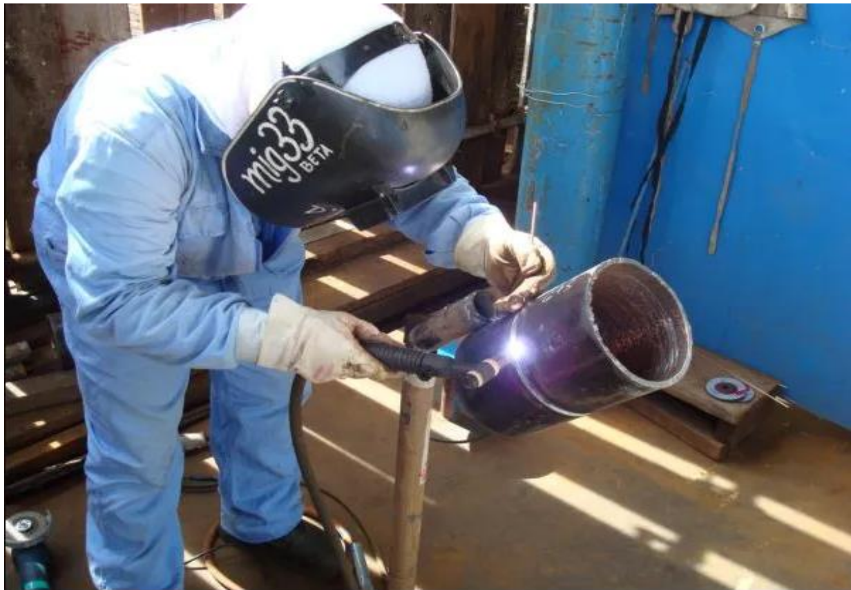
Figure3.2 : Gas Tungsten Arc Welding
