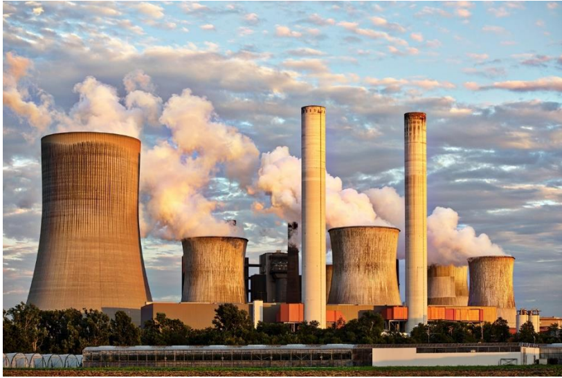
Fig: NPP Cooling Tower
